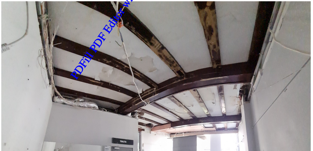
Foto 4. widok sufitu pod stropem S-2 (klatka schodowa) z elementami dekoracyjnymi prostych obić deskowych, do pozostawienia.
