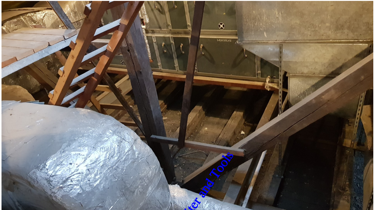
Foto 3. widok poddasza – strop S-2 (nad klatką schodową) – odsłonięte belki nośne wraz z drewnianą warstwą podsufitki
