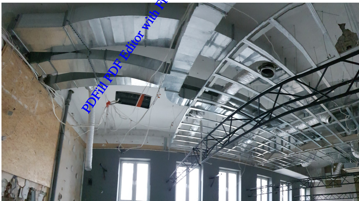
Foto 8. widok sufitu podwieszanego pod stropem S-3, S-4 (sala ćwiczeń) – istniejąca zabudowa sufitu podwieszanego i instalacji podwieszona do remontowanego stropu. Wymiana sufitu podwieszanego, podparcie punktowe instalacji wentylacyjnej i klimatyzacji w trakcie realizacji robót. Powtórne wykonanie zawiesi.
