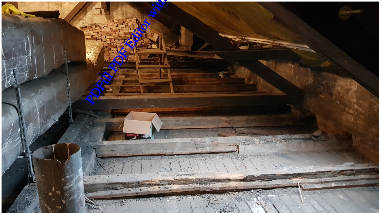
Foto 2. widok poddasza, konstrukcja drewnianego stropu - odsłonięte belki oraz drewniana warstwa podsufitki, widoczne łąty oparcia zdemontowanego ślepego pułapu – strop S-1
