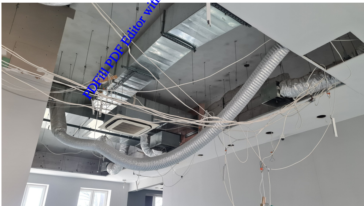
Foto 6. widok sufitu podwieszanego pod stropami S-3 i S-4 – istniejąca zabudowa sufitu podwieszanego i instalacji podwieszona do remontowanego stropu. Wymiana sufitu podwieszanego, podparcie punktowe instalacji wentylacyjnej i klimatyzacji w trakcie realizacji
