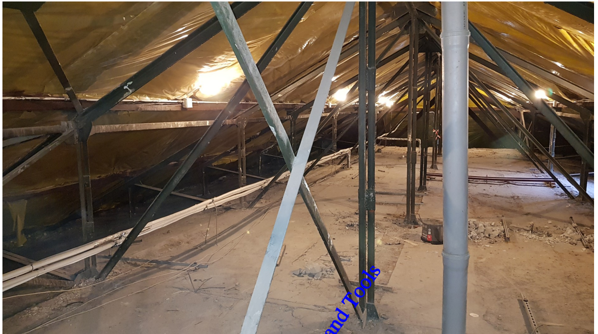
Foto 1. widok poddasza, konstrukcja płyt żużlowych opartych na konstrukcji kratowej więźby – strop w strefie S-3, S-4
