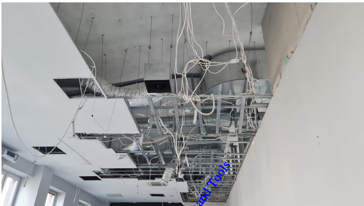
Foto 5. widok sufitu podwieszanego pod stropami S-1 i S-2 – istniejąca zabudowa sufitu podwieszanego i instalacji podwieszona do remontowanego stropu. Wymiana sufitu podwieszanego, podparcie punktowe instalacji wentylacyjnej w trakcie realizacji robót.
